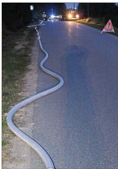
Eine Schlauchleitung wurde an der Weiherhausstraße verlegt.
